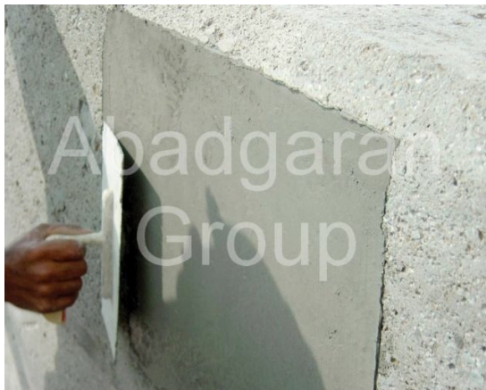
روش مصرف ترمیم‌کننده بتن E.M.REPAIR
