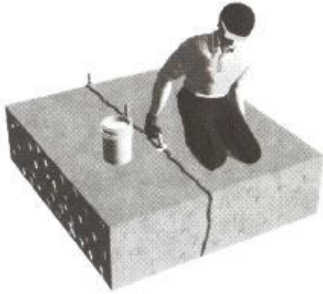
مرحله ۲- نصب شیرهای ورود مواد تزریق
