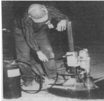
مغزه گیری برای تعیین توسعه ترکها
