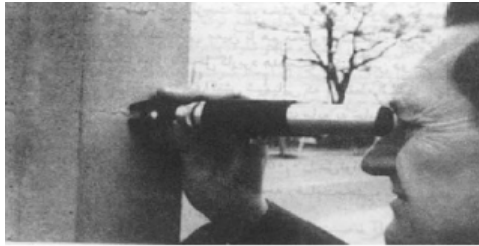
استفاده از یک میکروسکوپ کارگاهی برای تعیین عرض ترک
